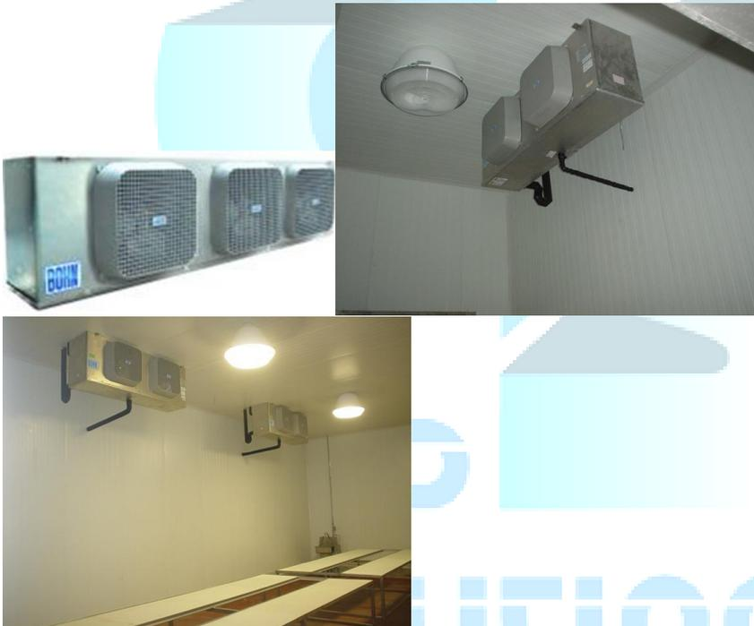
El Evaporador tiene como objetivo proveer una transferencia continua y eficiente de calor desde el medio que se desea enfriar, al fluido refrigerante. El medio que se desea enfriar puede ser un gas, un líquido o un sólido.
